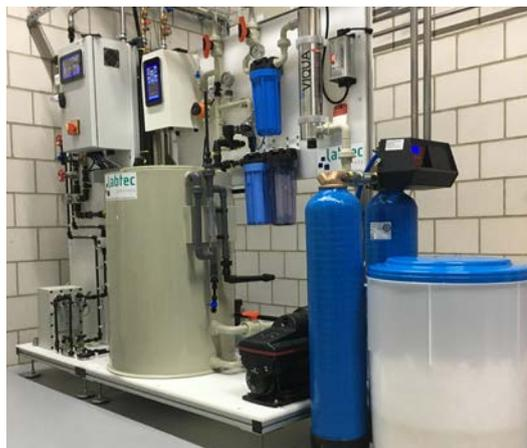
Eine RO/EDI System mit Tank 200 Liter und einer Verteilung über eine Ringleitung mit UV Bestrahlung und 0.2 µ Filtration
